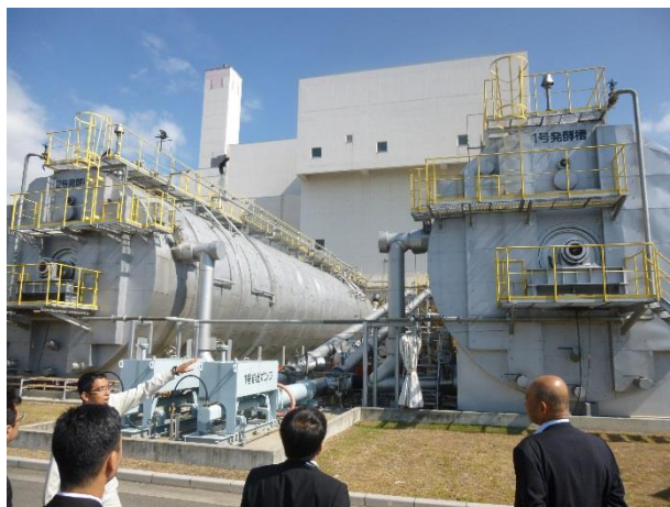
クリーンセンター外観
